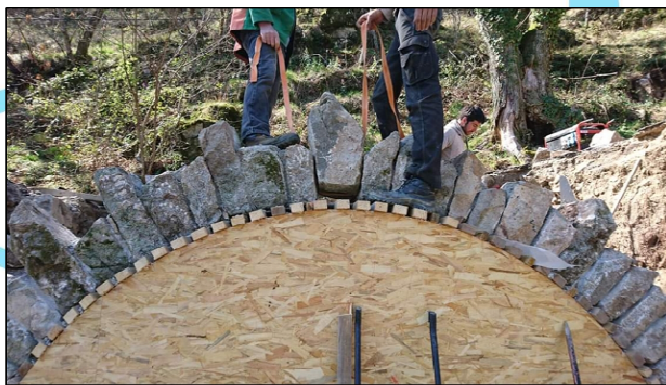
Pose de la clé de voute pierre sèche : La Coste/ Clovis Gros
